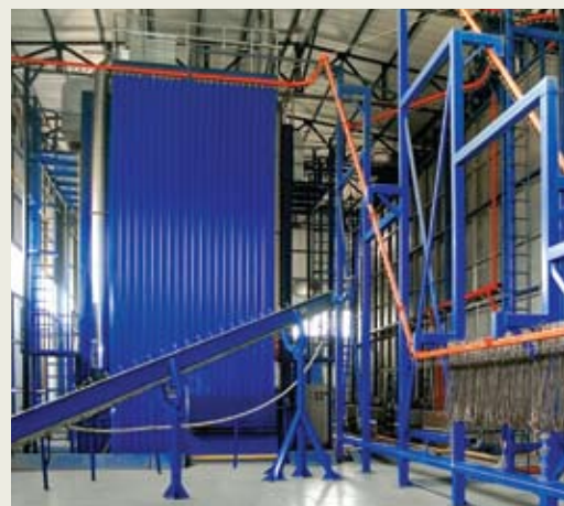
Вертикальная линия порошковой окраски
