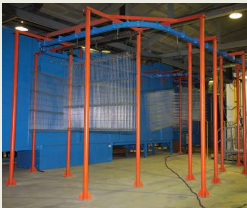
Покраска панельных секций в горизонтальной линии порошковой окраски
